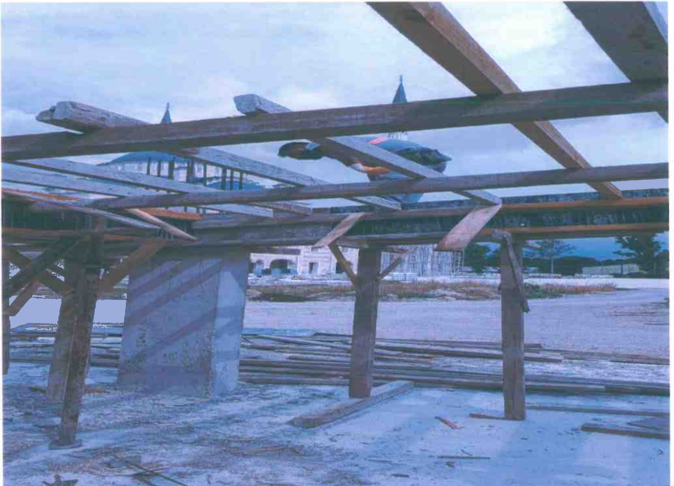
Yeni Şeker Camii Yanı İş Yeri Kalıp Kurulumu 2
