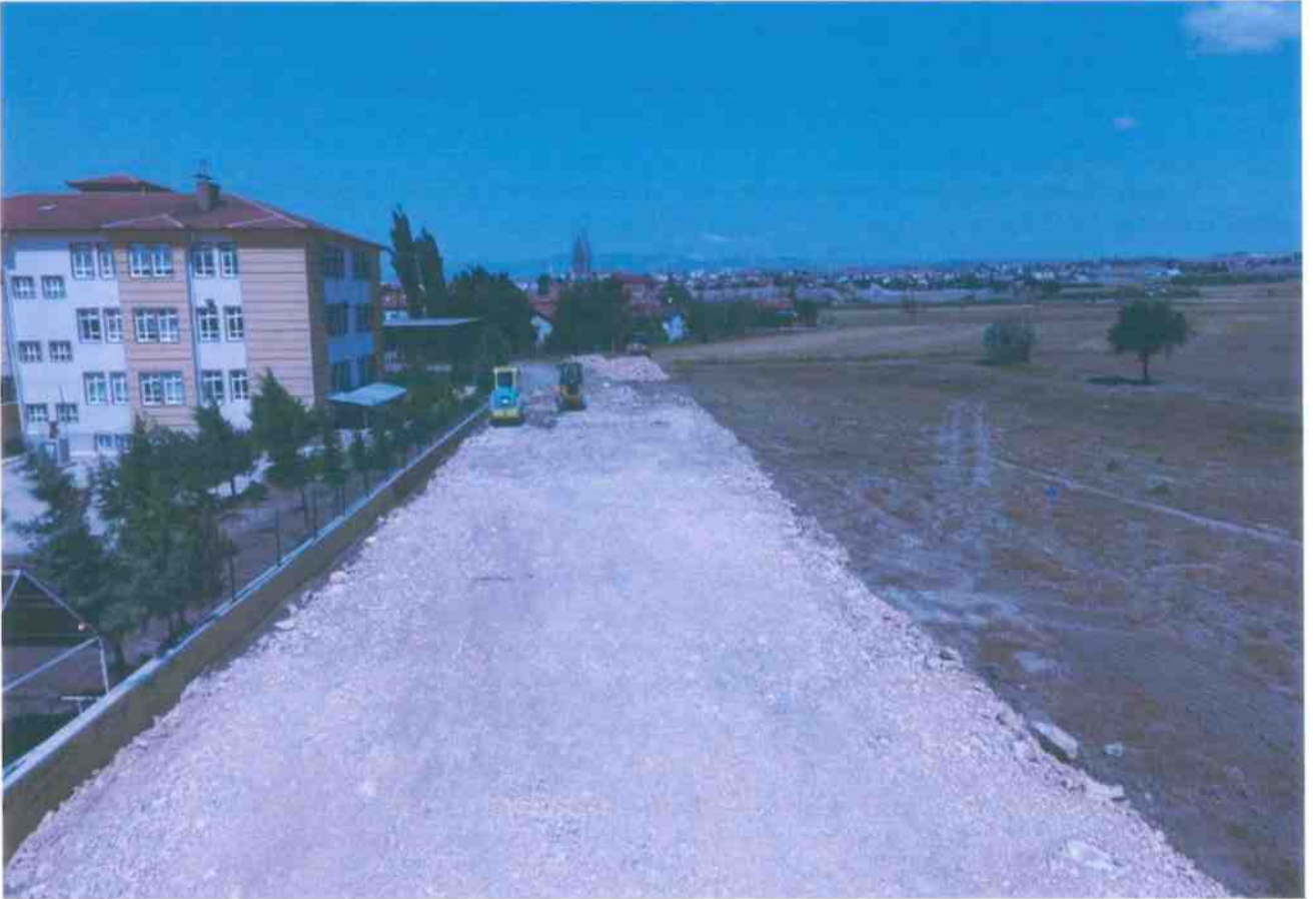
Asfalt Serimi Öncesi Kaba Malzeme Serimi ve Sıkıştırılması
