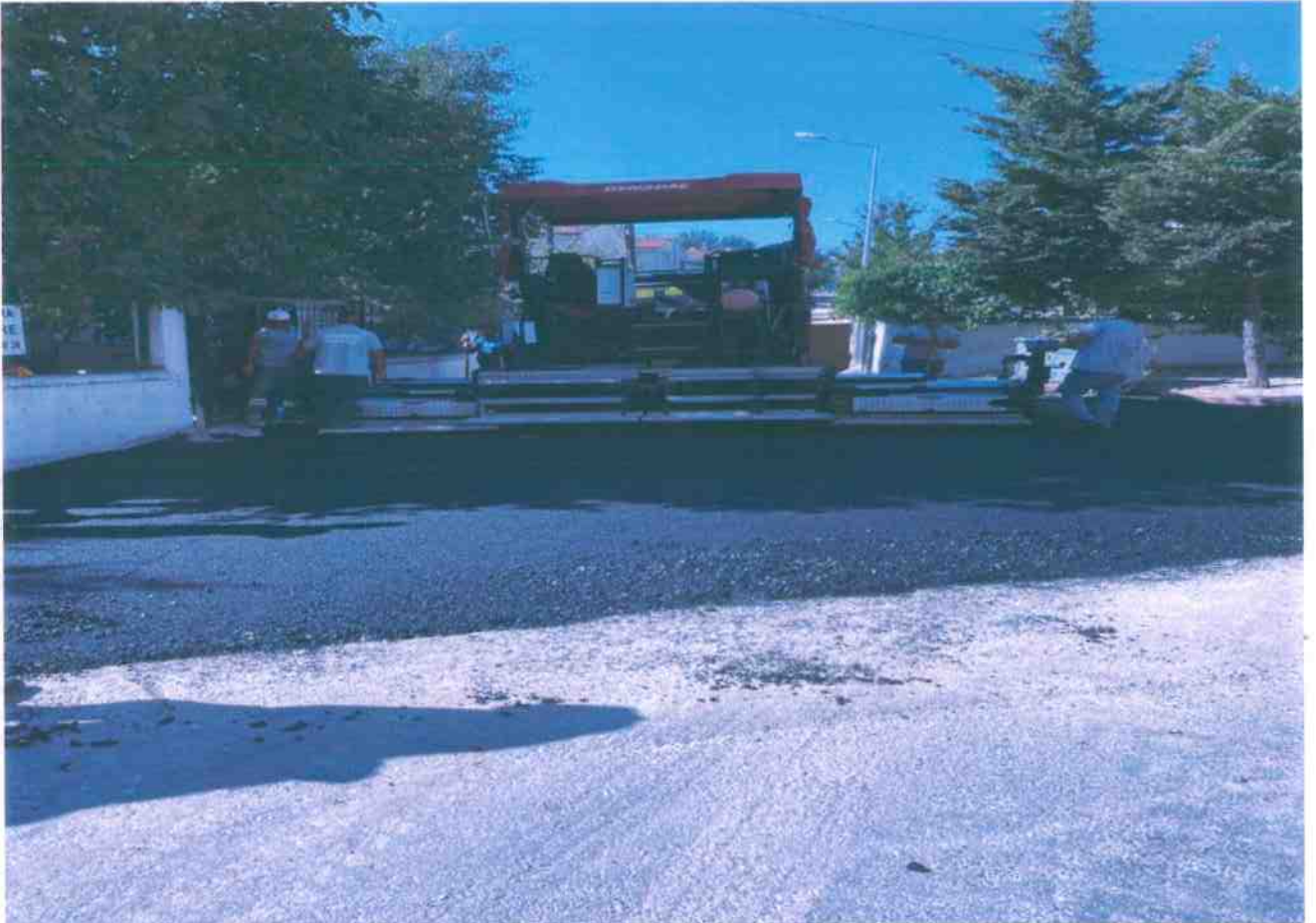
Osmanbey Sok. Asfalt Serimi 1
