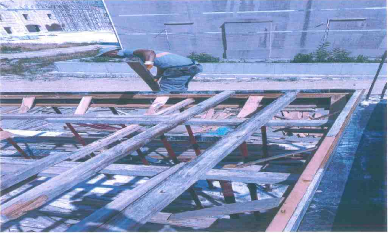
Yeni Şeker Camii Yanı İş Yeri Kalıp Kurulumu 1
