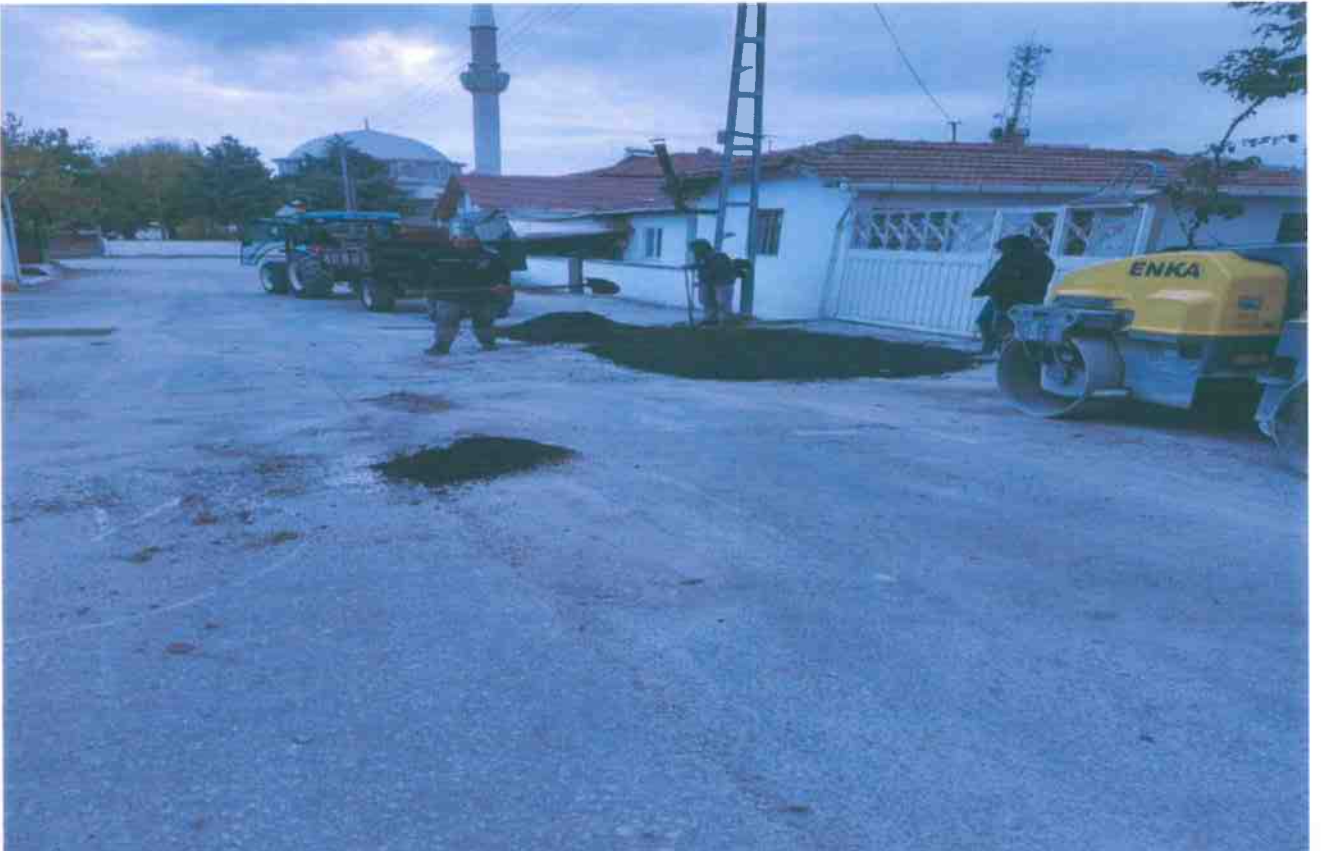
Asfalt Yama Çalışması 2
