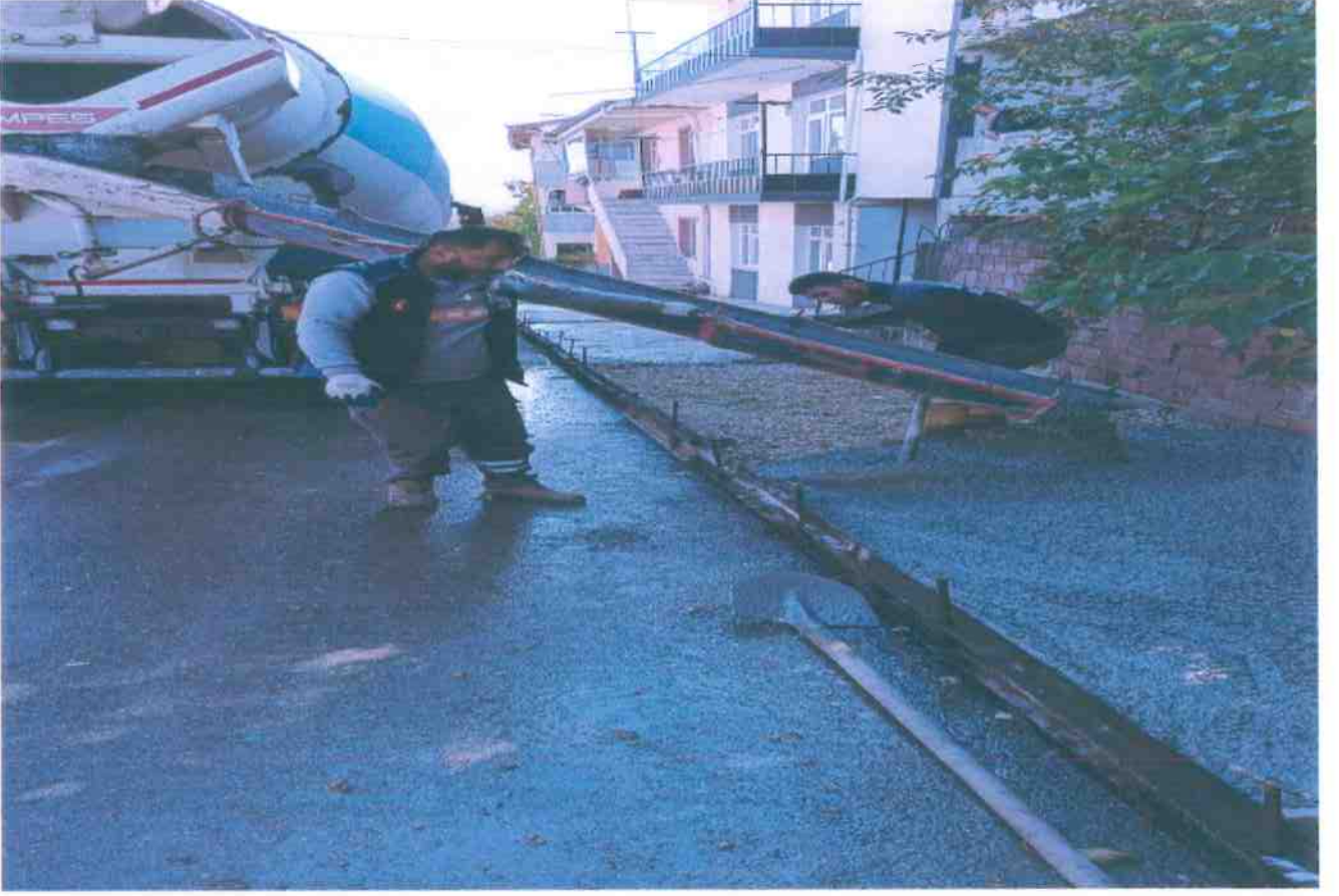
Kaldırım Beton Hazırlığı ve Beton Dökümü2
