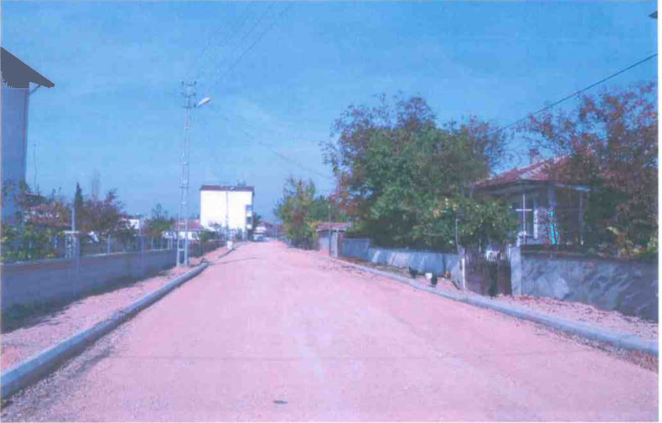
0,25 Malzeme Serimi ve Sıkıştırılması
