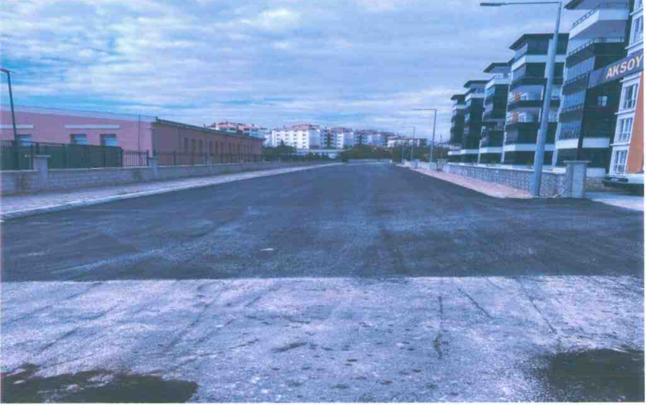
Emiralp Sok. Asfalt Serimi 2
