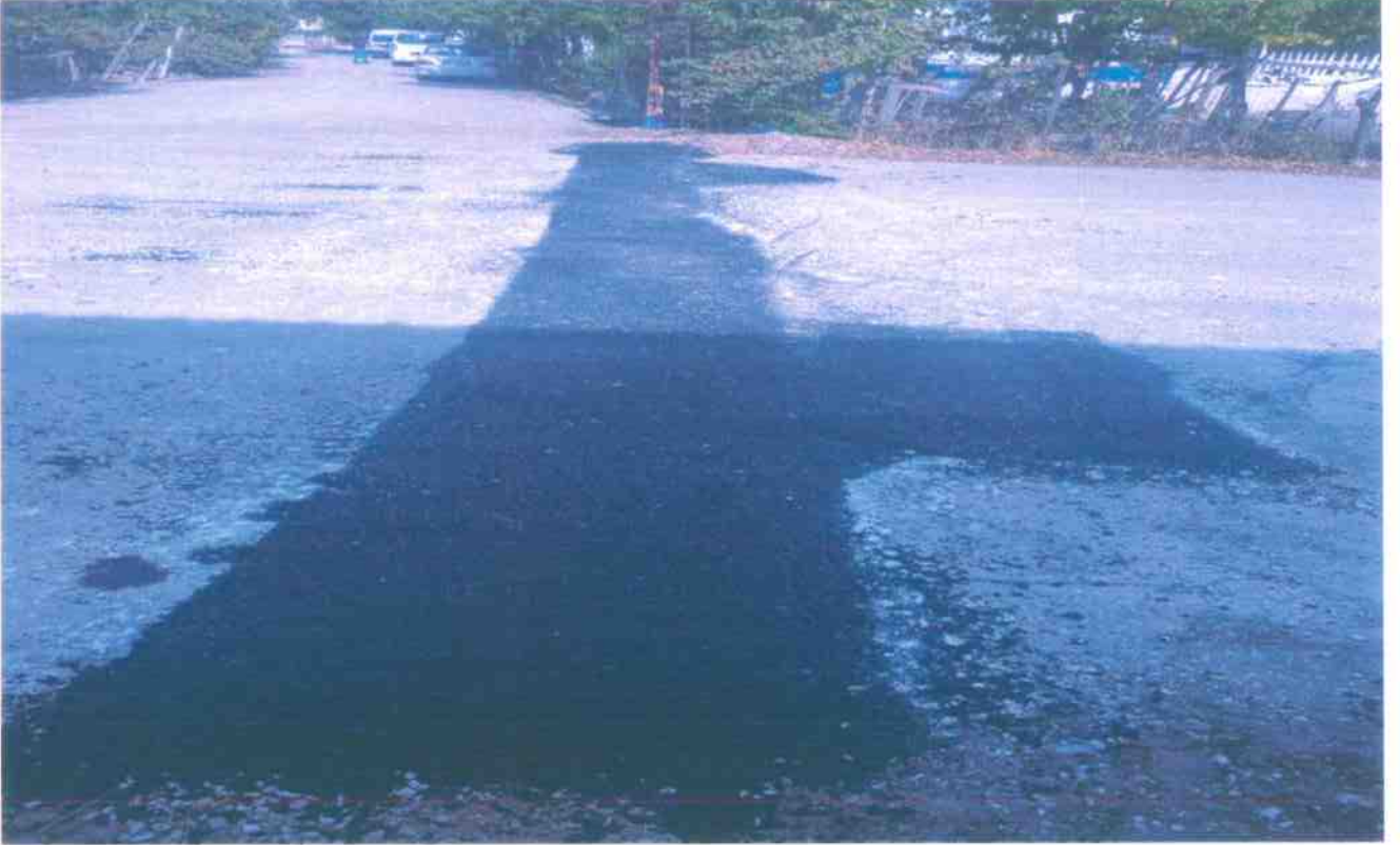
Asfalt Yama Çalışması 3
