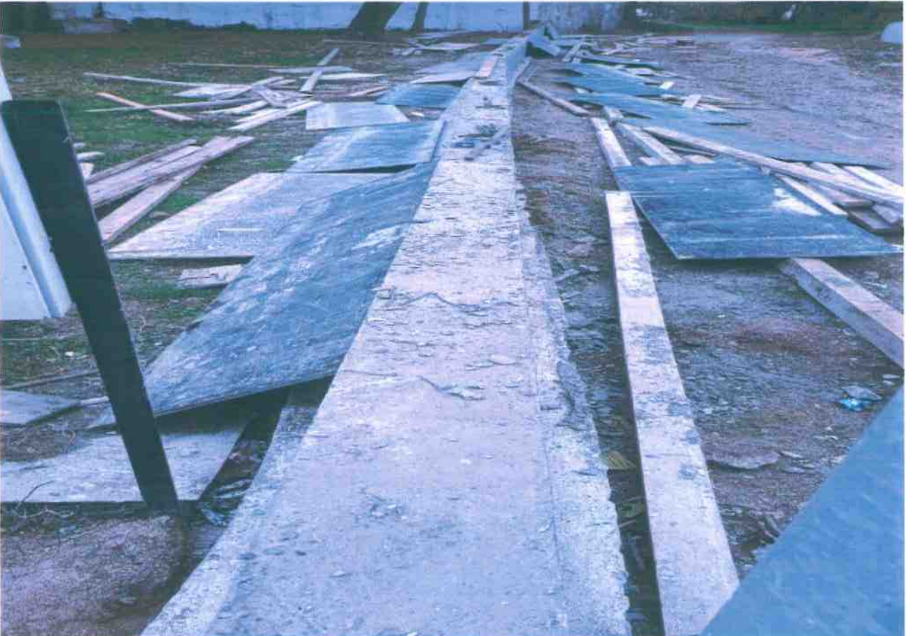
Engelliler Derneği Perde Kalıp Beton Dökümü 2
