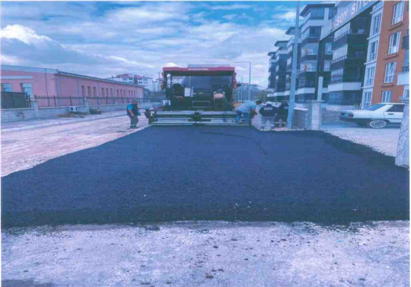
Emiralp Sok. Asfalt Serimi 1
