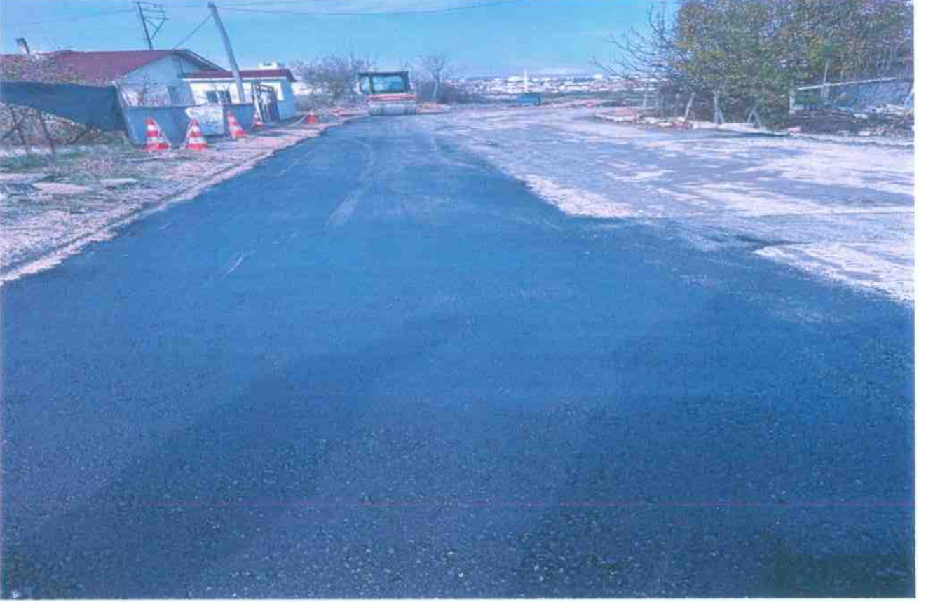
Asfalt Yama Çalışması1
